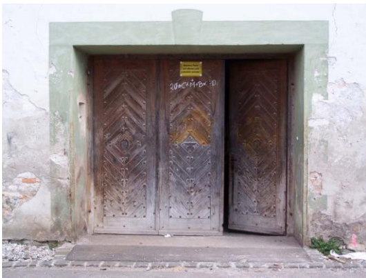
Bild: Zugangsbereich zur Alten Schäfllerei des Klosters Benediktbeuern. © Fraunhofer IBP
